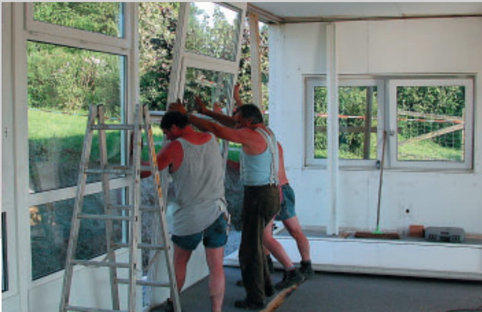
Effizienz in allen Arbeitsschritten, ob beim Einbau der Fensterfassade in ein mobiles Raumsystem in Birkmannsweiler (links) oder beim Bau einer Schule in Herbrechtingen (rechts)
